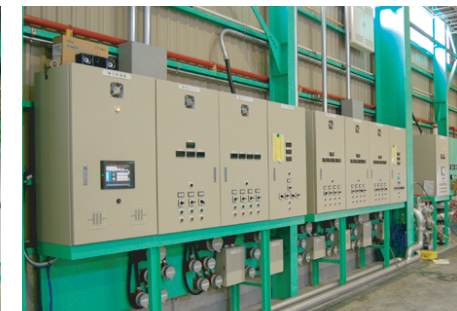
◎電気容量 300kVA ◎200V・400V級インバータ ◎耐圧テスト 70MPa ◎タンク 10,000ℓ ◎NAS 8級管理
