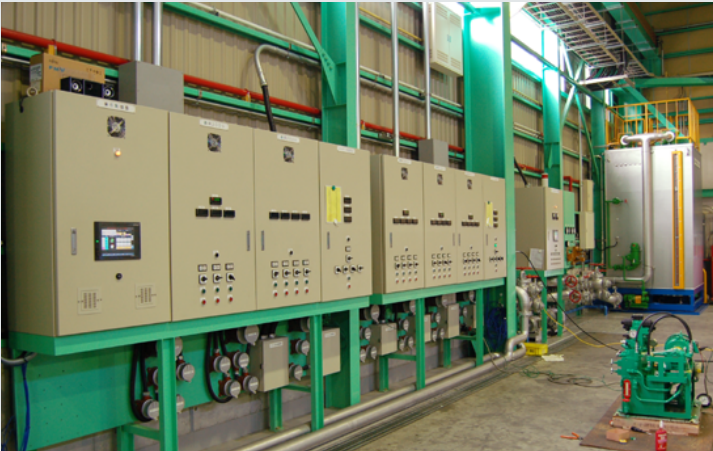
◎電気容量 300kVA ◎200V・400V級インバータ ◎耐圧テスト 70MPa ◎タンク 10,000ℓ ◎NAS8級管理
