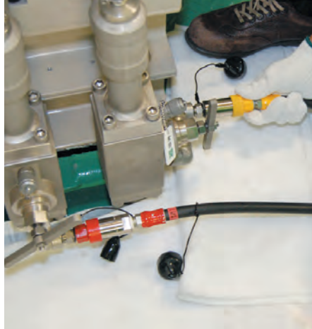
多機能バルブとホースの接続状況
